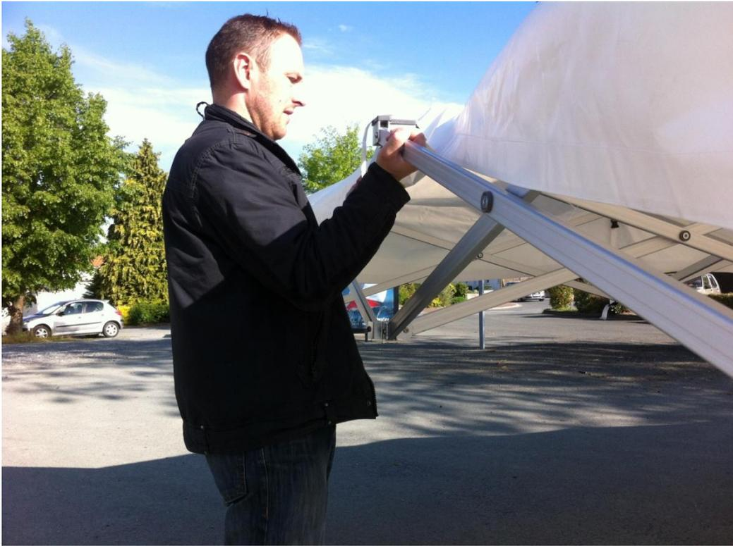
***Ecarter la structure jusqu'au blocage des goupilles sur les 6 poteaux***
